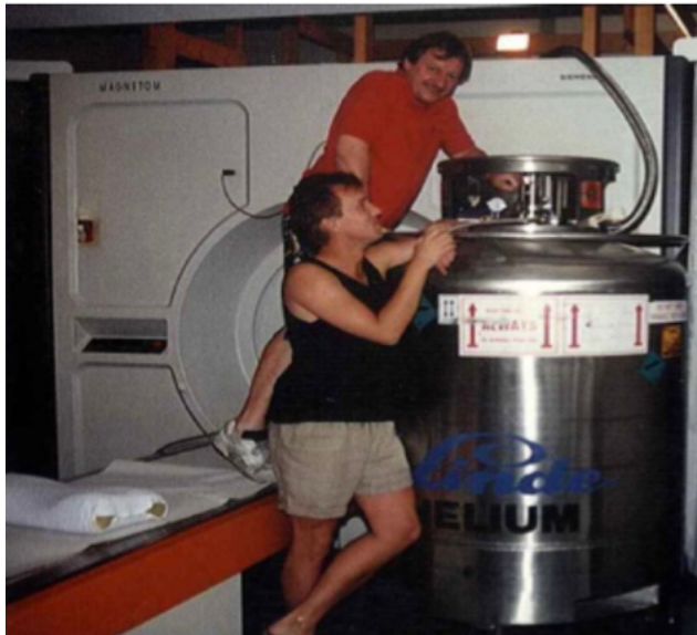
Befüllung des supraleitenden Magneten mit flüssigem Helium während der frühen Betriebsphase des MRT in Würzburg. Noras war an der technischen Planung und infrastrukturellen Vorbereitung des Standorts beteiligt.
