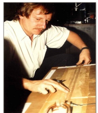
Erste Ausführung einer unter dem Patienten verschiebbaren Wirbelsäulenspule, entwickelt in Würzburg während der frühen MRT-Entwicklungsphase (Noras Medizintechnik).
